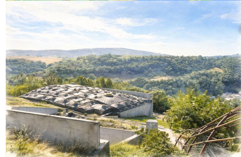
● Bâtiment principal de Micropolis © Photothèque Micropolis
